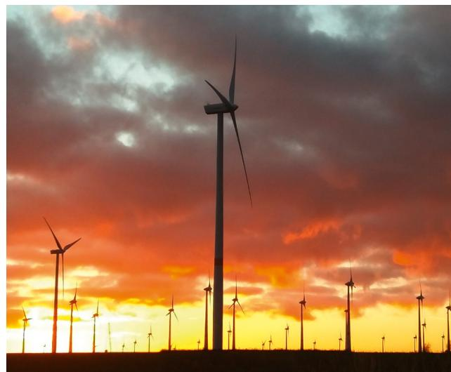
Durch den Einsatz einer Abschaltautomatik in den geplanten Windenergieanlagen können die Beschattungszeiten soweit reduziert werden, dass diese Werte eingehalten werden können.
